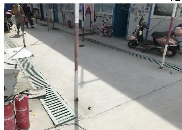
施工场地排水沟
