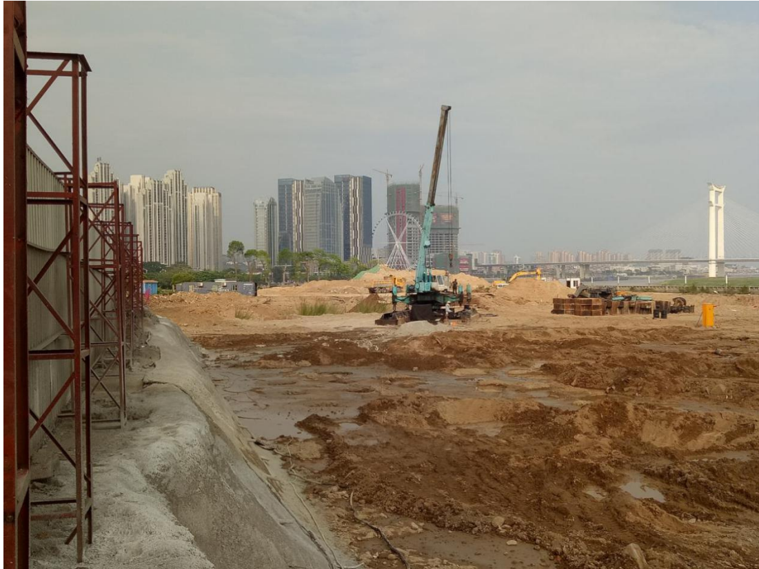
项目部监测照片
