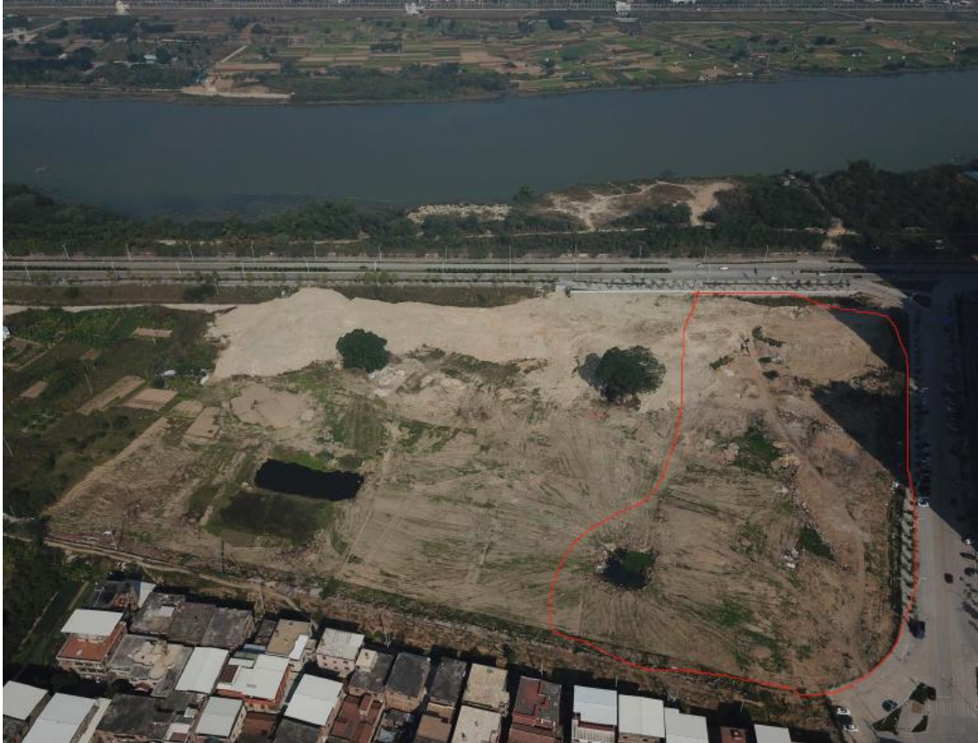
施工准备期现状
