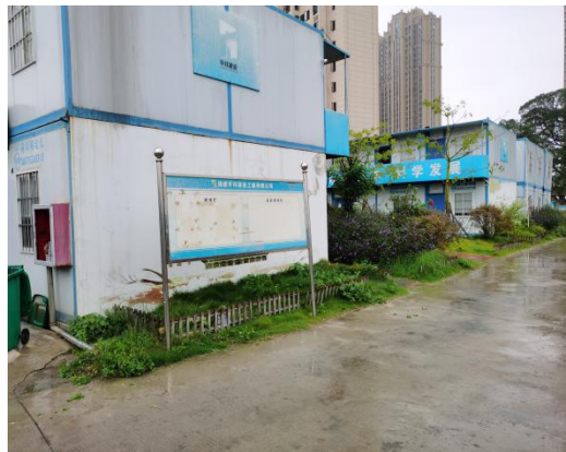
施工场地情况
