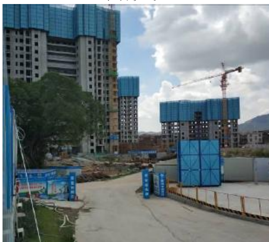
主体施工照片
