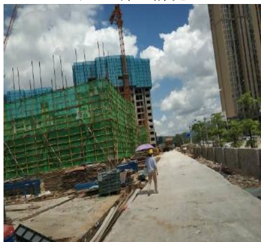
主体施工照片
