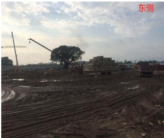
场地平整开挖
