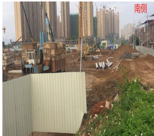
桩基础施工
